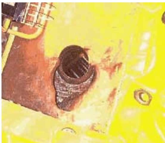
Figure 2 : Photographie de l'endommagement découvert
