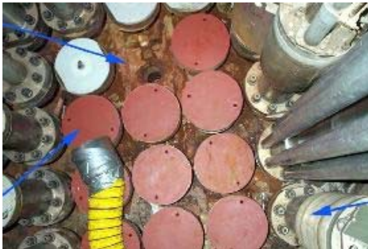
Figure 4 : Localisation de la cavité sur le couvercle du réacteur
