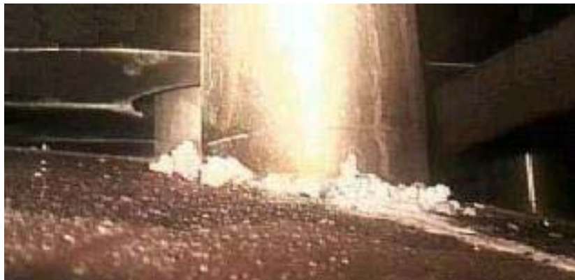
Figure 6 : Cristaux d'acide borique sur la surface d'un couvercle de cuve
