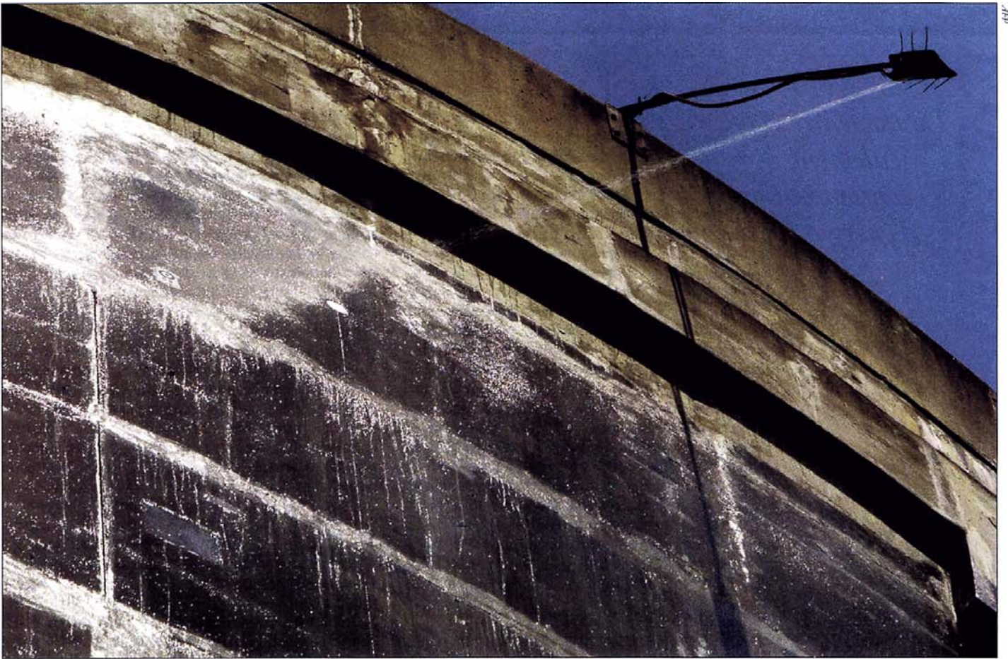
Le nucléaire censé répondre à l'effet de serre ne résiste pas à la canicule ! On voit ici l'arrosage bricolé à la hâte de la centrale de Fessenheim (Alsace) durant l'été 2003 : la température intérieure ne devait pas dépasser 50°C sauf à endommager des composants électroniques...
